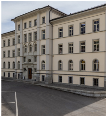
Abb.5: Das Schulhaus in Schwyz
