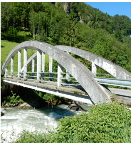
Abb.7: Die Betonbrücke über die Muota in Hinteribach
