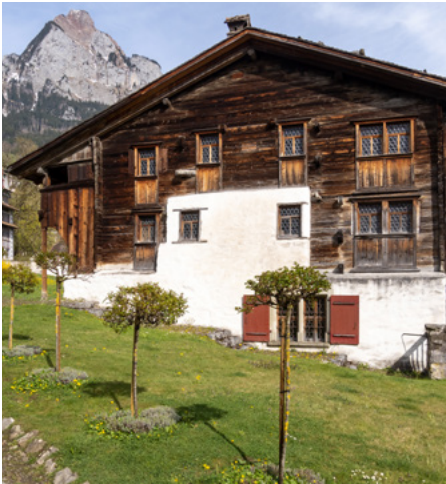
Abb.1: Ein altes Wohnhaus: Haus Bethlehem in Schwyz, erbaut um 1287
