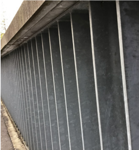
Detailaufnahme eines Geländers
