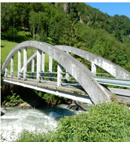
Abb.7: Die Betonbrücke über die Muota in Hinteribach
