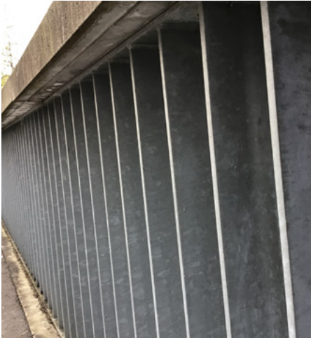
Detailaufnahme eines Geländers
